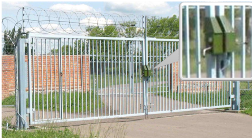
Рисунок 6 – Замковий пристрій на воротах лінійної частини сигналізаційного комплексу КС-185 «Гоби»
