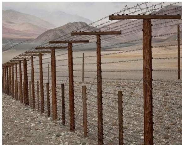
Рисунок 1 – Сигналізаційне загородження сигналізаційної системи С-100 «Скала»
