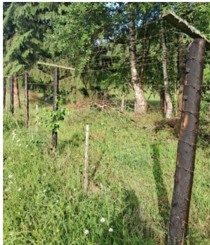
Рисунок 2 – Сигналізаційне загородження сигналізаційної системи С-175 «Гардина»
