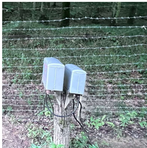
Рисунок 4 – Блок лінійний і коробка розподільча сигналізаційної системи С-175 «Гардина»
